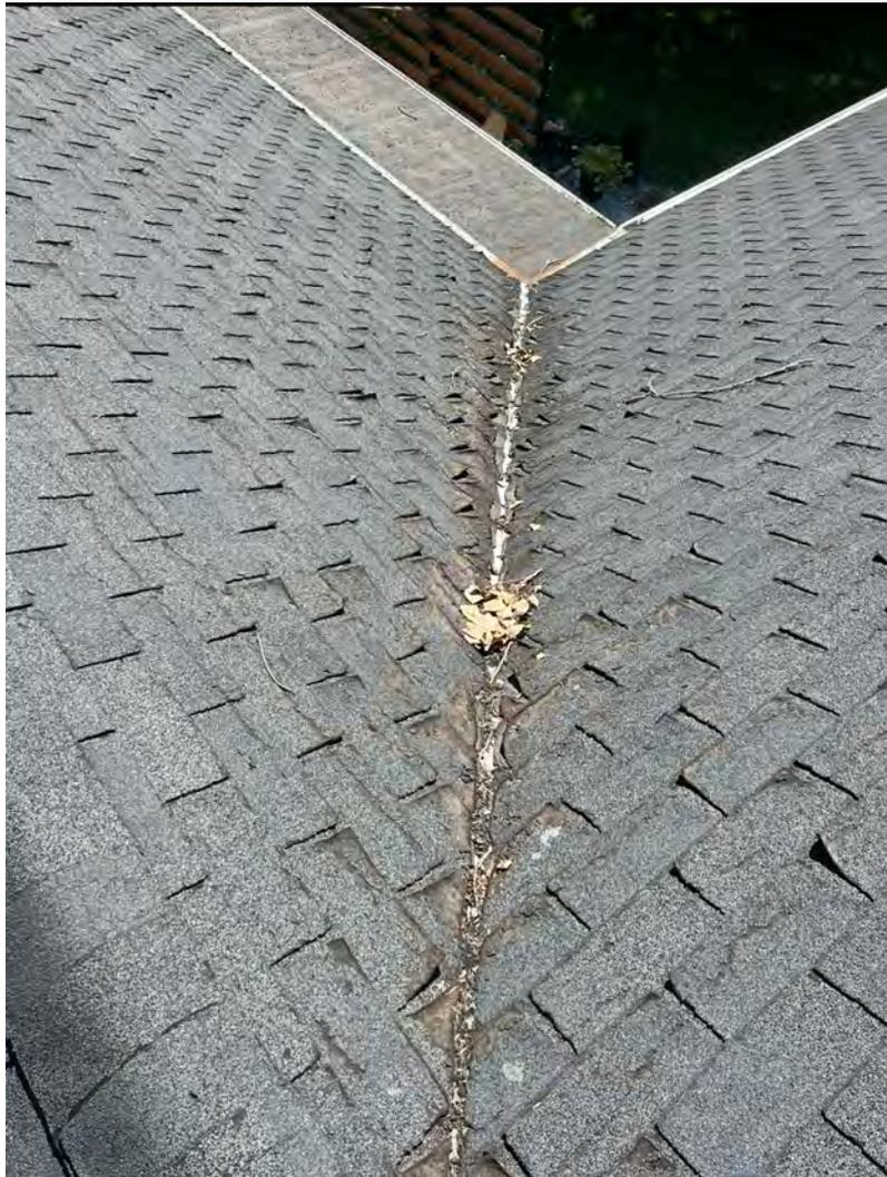
La noue est la jonction deux pans de toiture ayant un angle concave. L'angle entrant formé par ces deux pans va donc canaliser les eaux afin de créer un ruissellement de l'eau vers la gouttière. La noue est donc un endroit de la toiture très propice à l'infiltration d'eau. Les toitures avec des noues nécessiteront donc l'installation de solins qui viendront protéger le toit et l'entretoit (pontage et combles) des infiltrations potentielles.
