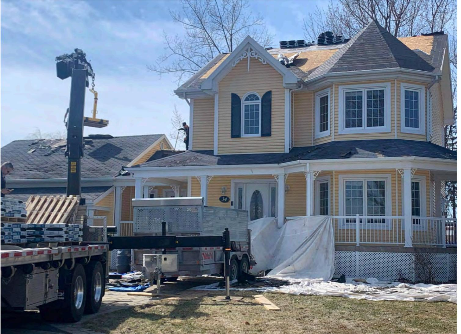
Sur chaque chantier de toiture il est impératif de placer des toiles de protection pour tous ce qui est autour de la résidence . Patio, balcon, arbuste , végétation , pavé unis , piscine et autres sont tous des éléments qui peuvent être endommagé lors de la réalisation des travaux . Il est dans notre mandat de veiller à la sécurité des biens et la sécurité des travailleurs ainsi que du client .
