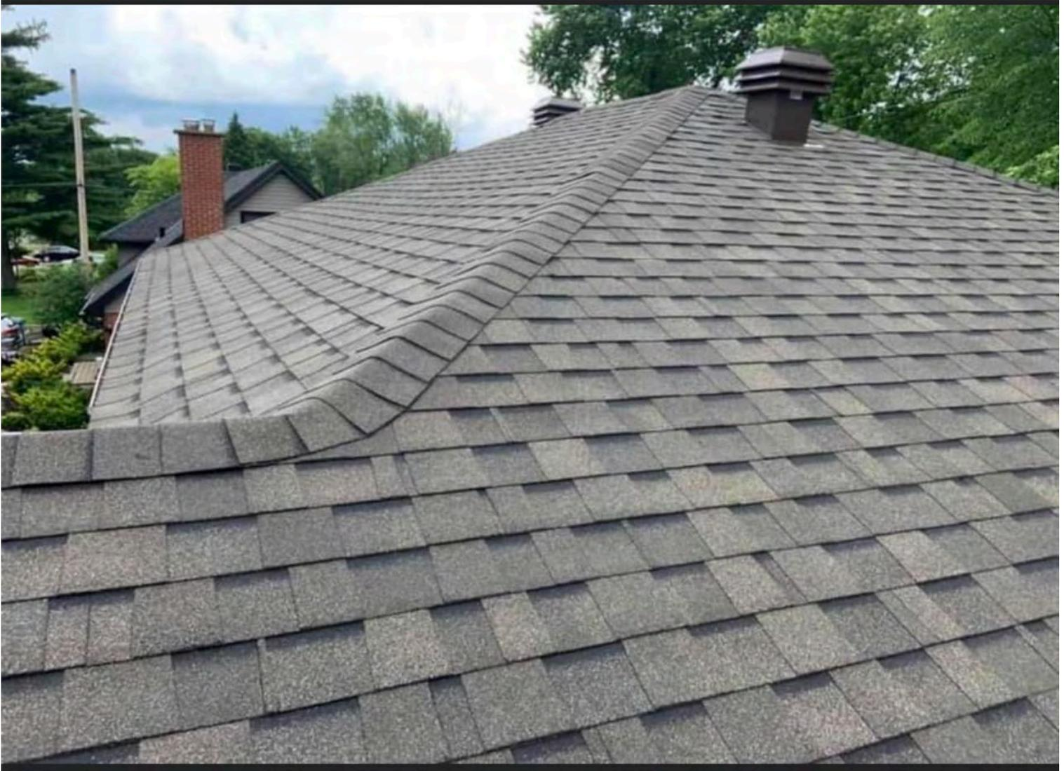
Les bardeaux de faîte pré-taillés Hip & Ridge 12 sont nécessaires aux jonctions des versants du toit; plus besoin de découper des bardeaux pour protéger les zones vulnérables des faîtes et des arêtes du toit. Les bardeaux sont couverts d'un granulat résistant aux algues et un scellant adhésif procure une meilleure résistance aux vents. S'utilise entre autres avec les bardeaux architecturaux Cambridge, Dynasty et Royal Estate (couleurs correspondantes).
